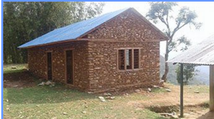
(खोटाङ्ग जिल्लाको हौचुर गाविसमा निर्माण गरिएको पुस्तकालय भवन)
